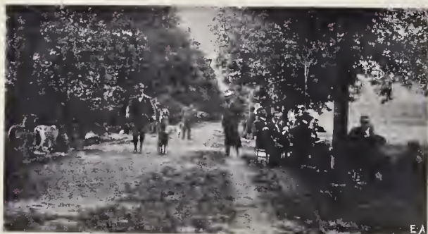
LE PROVE SUL TERRENO ALLA VENERIA.
